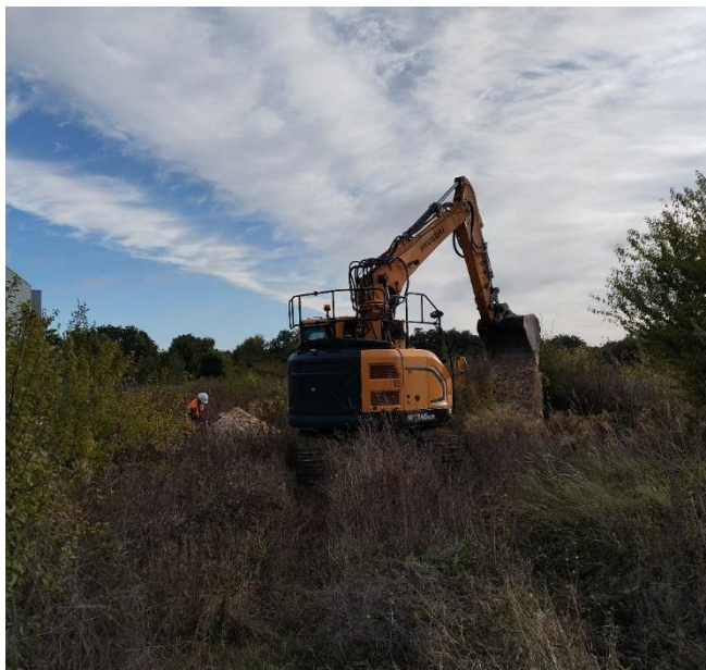
Figure 14 : Sondages réalisés à la pelle mécanique
